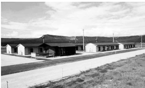
ภาพที่ 1 การก่อสร้างบ้านพักชั่วคราวที่ทำมาจากไม้
