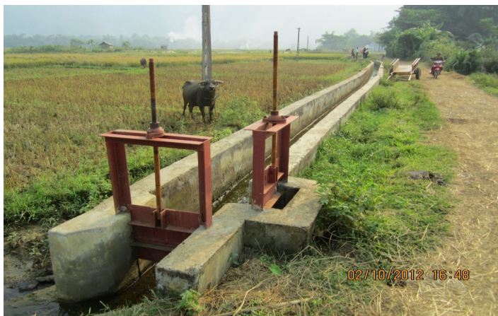
ประตูปิด-เปิด ระบายน้ำ ในระบบชลประทานที่ได้รับความช่วยเหลือจาก JICA ที่มา: นักวิจัย
