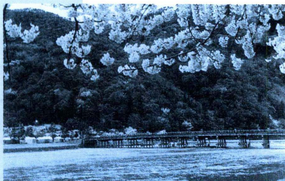
สะพานทอดข้ามแม่น้ำที่ตำบลอะราฮายามะ
